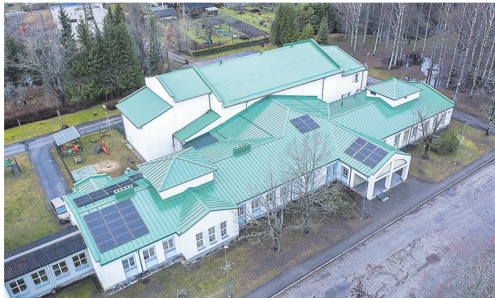
Eidapere Kultuurikeskuse katusele paigaldatud päikesepaneelid hakkavad tootma elektrit.
